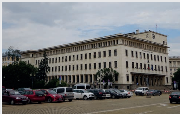
↑ Het beeld waarmee we aan de slag gaan: het gebouw staat niet mooi recht.
